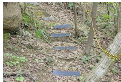
中津江行者様参道整備（階段工設置）
