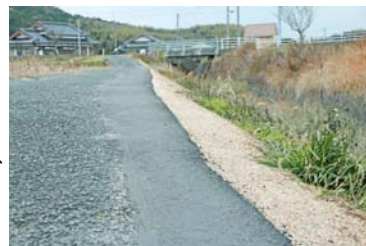
井南区舗装工
