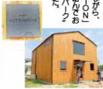
ミュージエ・オートマトン 建設中の「musée AUTOMATON」
